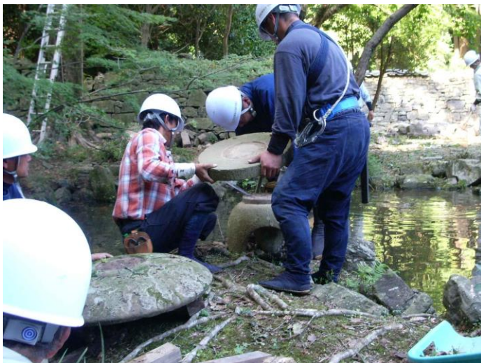
技術見学会中の燈籠の据え直し(万松院)
