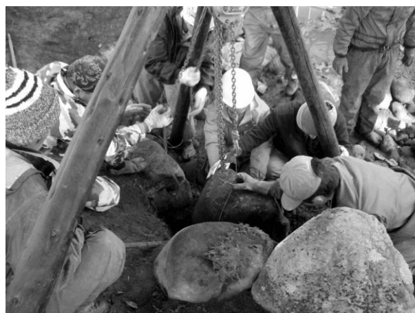
(上下の4枚とも、護岸石組の据え直しの様子。)
