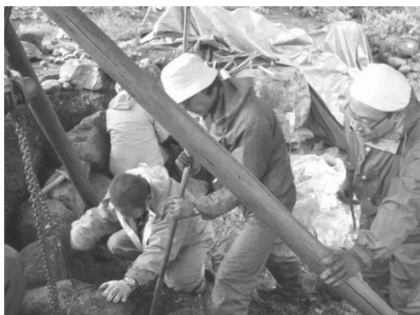
(上下の4枚とも、護岸石組の据え直しの様子。)
