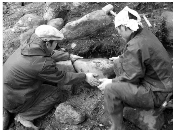
(上下の4枚とも、護岸石組の据え直しの様子。)
