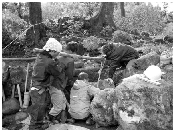
(上下の4枚とも、護岸石組の据え直しの様子。)
