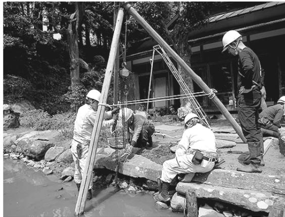
実技研修の様子（護岸石組の据え直し）
