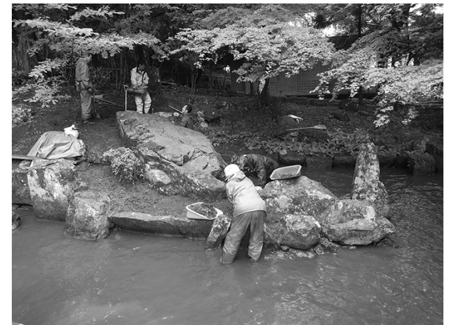
実技技能研修の様子（地割修理）
