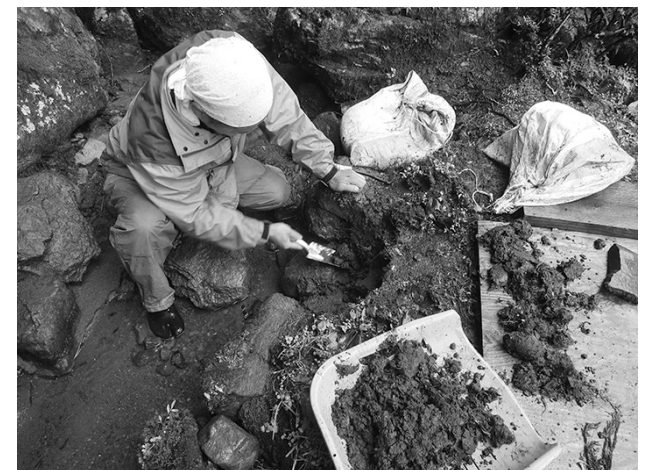
実技技能研修の様子（石組修理）
