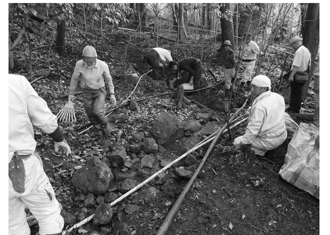
実技技能研修の様子（地割修理）
