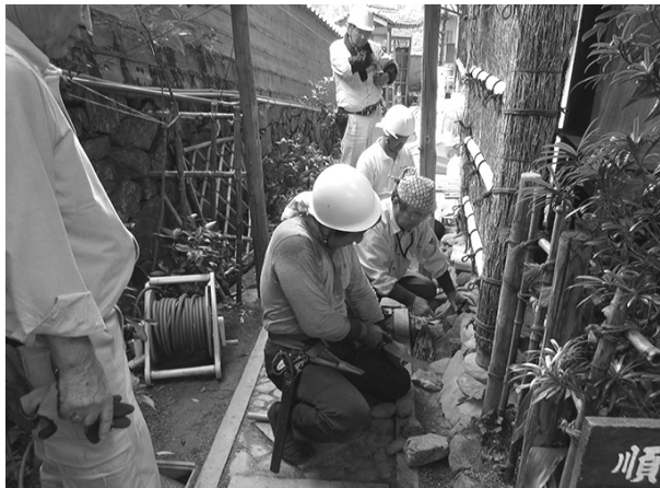
臥龍山荘庭園 実技研修の様子（袖垣の補修）
